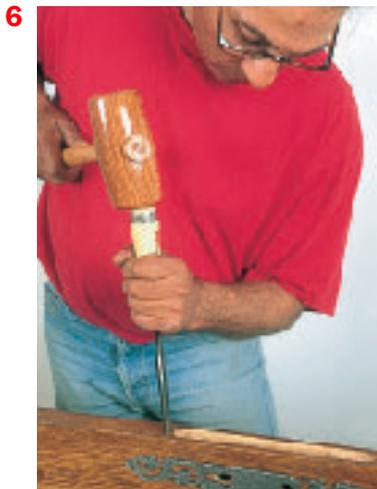
**6. Rectifier l'encastrement de la têtère au ciseau à bois, suivant le tracé. Pour entailler l'extrémité, tenir le ciseau verticalement et le frapper au maillet.**
