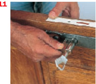
**11. Placer la serrure dans son logement et enfiler le cylindre (par exemple, un cylindre à pompes qui offre un très bon niveau de sûreté).**
